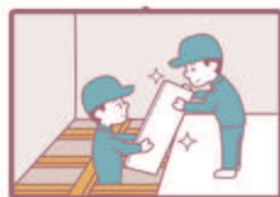
② 床に断熱材を入れる
