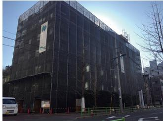
ただいま、則武工務店では中央区女性センターの外壁工事を行っています。老朽化に伴い、雨漏りなどの発生を防ぐために、外壁の塗り替え、タイル面の補修、屋上の防水を行います。左の写真は足場をかけたところです。完了は3月下旬を目標に施工しております。則武工務店の懸垂幕もかかっているため、近くを通った際は、少し上を見上げてみてくださいね。
