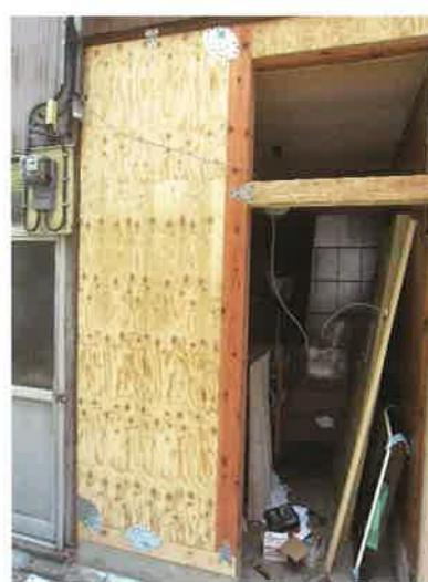
⑤構造用合板を設置し、接合部を金物で補強します。
